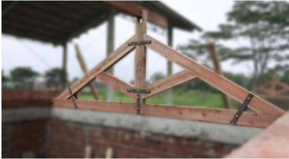
Gambar III.15 Pemasangan Plat Baja Pada Kuda-Kuda Kayu
