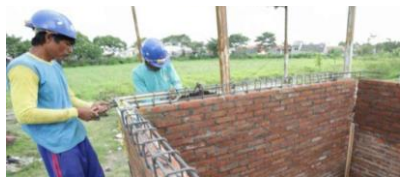
Gambar III.31 Perangkaian Tulangan Balok Keliling/Ring di atas Dinding
