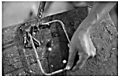
Gambar III.11 Tekukan Ujung Tulangan Begel
