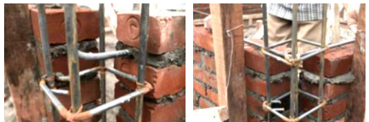
Gambar III.26 Pemasangan Angkur Besi Sebagai Pengikat Antara Kolom
